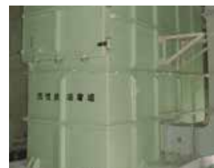
AC 形 ( 活性炭吸着塔 )
