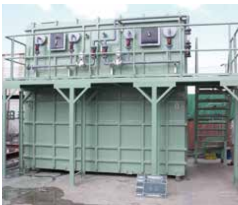
■生物脱臭塔施工例
