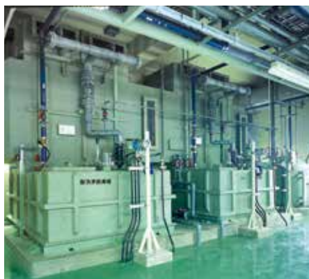
■横型薬液洗浄脱臭塔施工例
