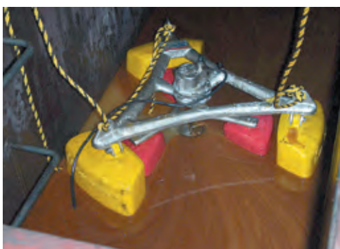
集中クーラント槽に設置
